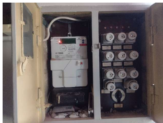
fot. 6 tablica główna z bezpiecznikami
